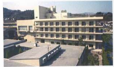
ゆたか寮竣工 (1981)
