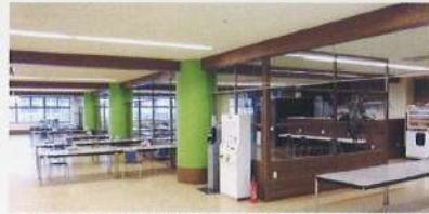
▲2013.2.28 第1作業棟1階改修工事終了
