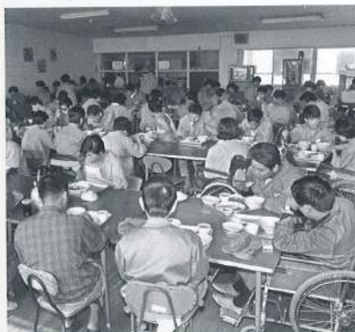
旧事務所棟内の食堂 (1968)
