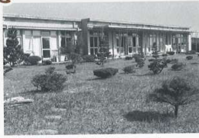
管理棟に続く九重寮 (1965)
