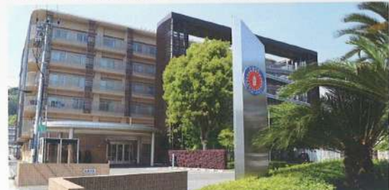
▲2012.3.8 新本館(耐震化整備宿舍改築事業)竣工
