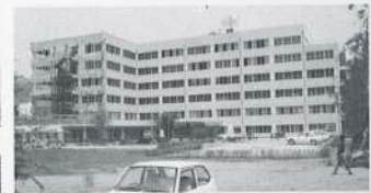
▲1971.4 本館(鉄筋6階建)落成
