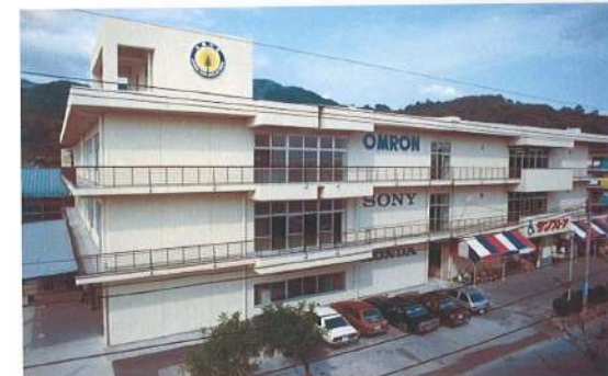
▲1981.10 第1作業棟落成、操業開始
