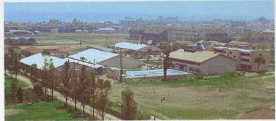
▲1968.2 第3・4期工事完了後
