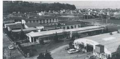
▲1966.7 九重寮・鶴見寮・由布寮・扇寮
