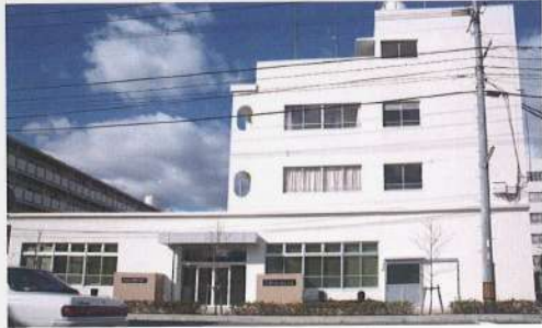
福祉工場棟撤去 (2010)
