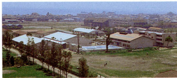
▲1968.2 第3・4期工事完了後
