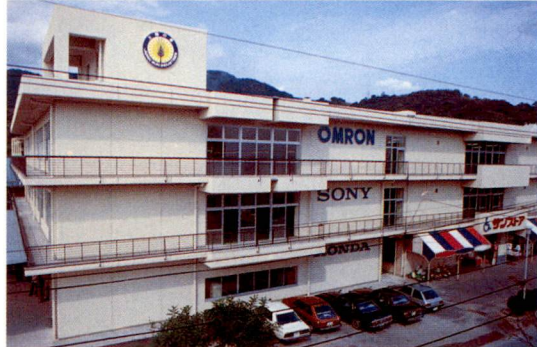
▲1981.10 第1作業棟落成、操業開始
