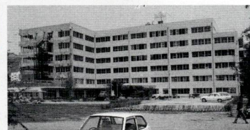
▲1971.4 本館(鉄筋6階建)落成
