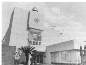
職能開発センターが完工
