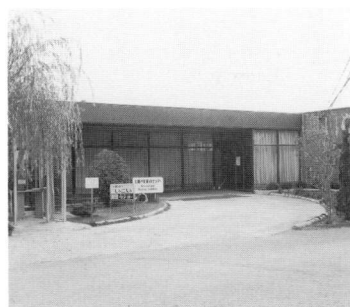
研修センター「憩いの家」 正面玄関
